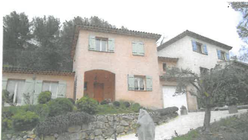
La maison à droite (blanche) est en zone Bleue Ra. La maison de monsieur Cataldi, située à gauche (Rose), est en zone Rouge.
