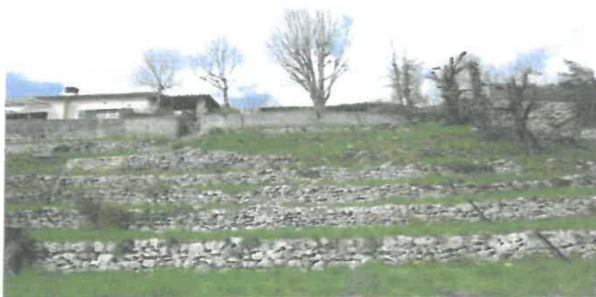
Terrain en terrasses soutenues par des murs en pierres sèches Le secteur GRa comprend la maison et la partie au Sud (à droite sur la photo).
